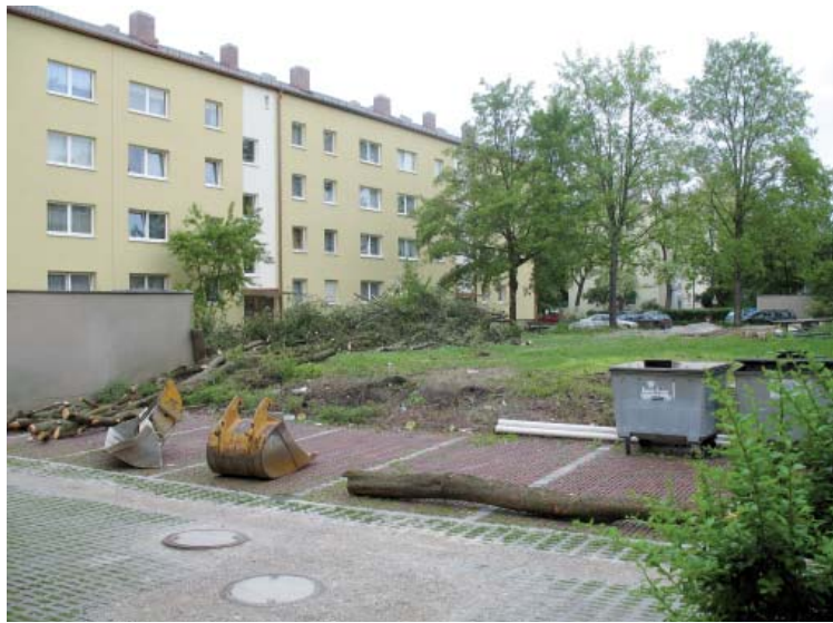
Baumaßnahmen „wohngrün.de“ in einer GEWOFAG-Siedlung
