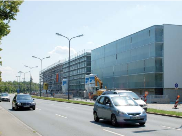
Lärmschutzbebauung Innsbrucker Ring / Bad- Schachener-Straße
