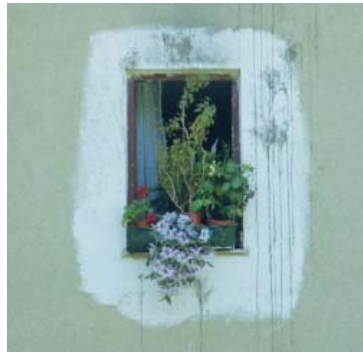
Fenster Gotteszeller Straße
